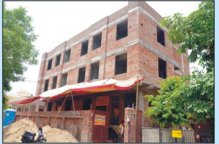
निर्माणधीन बालिका छात्रावास सावित्री बाई फूले भवन का वर्तमान स्वरूप
